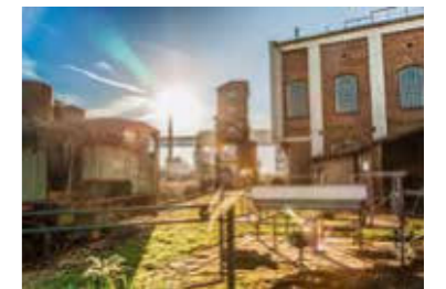
Pittoreskes Relikt regionaler Bergbaugeschichte: die Brikettfabrik Herrmannschacht.
